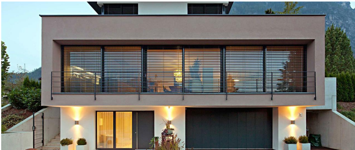
Abbildung 22 Außen angebrachte Raffstores 63
