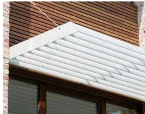
Abbildung 37 Horizontaler Sonnenschutz mit starren oder beweglichen Lamellen 86
